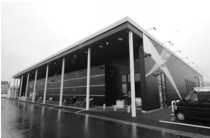
カラーリングの変更などでイメージを刷新した外観
